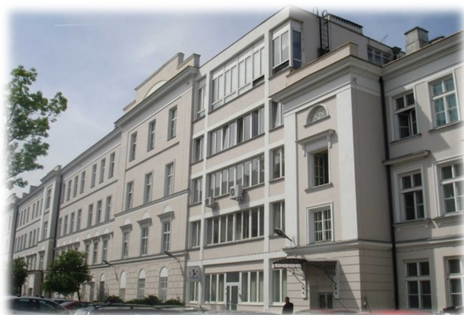
Budynek Instytutu Maszyn Matematycznych PAN przy ul. Krzywickiego 34 w Warszawie źródło: Archiwum IMM
